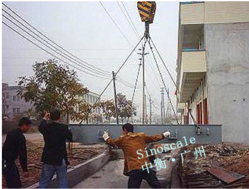
吊装地磅，请 8T 以上吊车过来吊才行，一个小时可以吊完，六百元左右
