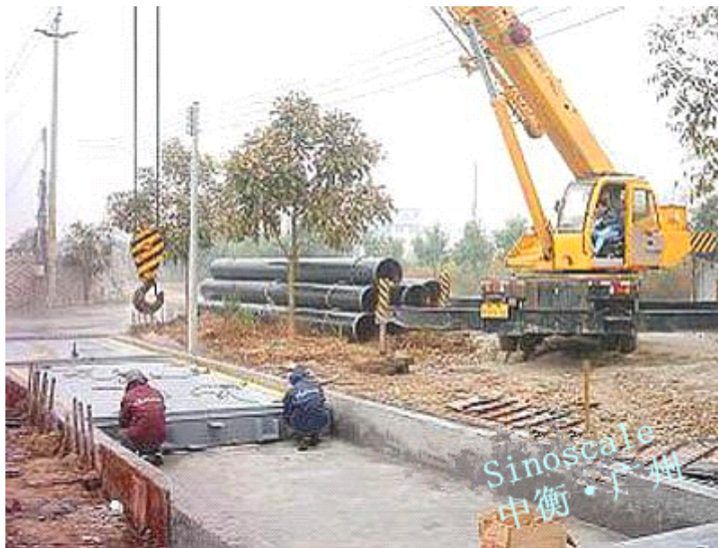
调整地磅，穿线
